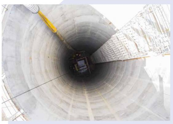
l'évacuation du tunnel de Pinchat par une galerie et des escaliers remontant à la surface. Le troisième puits -Champel - se trouve sur le tracé du tunnel du même nom.
