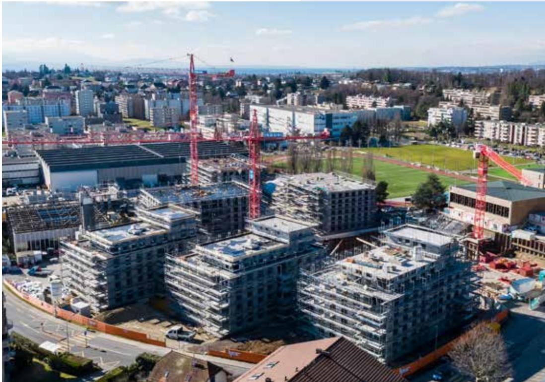
le radier et les décrochements des bâtiments A2 et A1. Un parking commun à tous les bâtiments, mais aussi des caves, des locaux techniques et des abris anti-atmosphériques occupent toute la surface sur un niveau de sous-sol. Les dalles des niveaux supérieurs ont été coulées en place au fur et à mesure, selon un déroulement en escalier. La seconde phase du chantier a concerné la partie sud. Tous les bâtiments ont été élevés sur le principe murs-piliers préfabriqués et dalles coulées en place.
