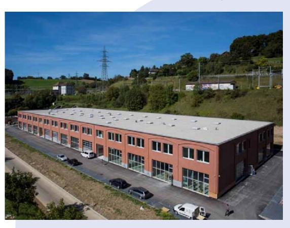
des travaux spéciaux, préalables à l'intervention d'Induni, ont été nécessaires: plus de 800 inclusions rigides (pieux) sont venues augmenter sa capacité portante et réduire sa compressibilité. Les deux objets ne disposant pas de sous-sol, des murs en béton ont été construits à même le radier à l'emplacement des cages d'escalier et d'ascenseur.
