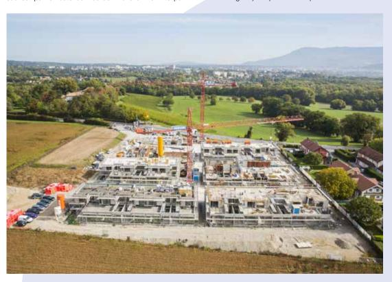
des clôtures MÜBA simples côté champs, avec filets côté villas et tôlées côté route, le chantier comprenait deux grues - une ancrée et une posée sur des puits -, desservies par une centrale à béton. Des zones de stockage étaient prévues pour les matériaux d'excavation (réutilisés pour le remblaiement) et pour la terre végétale (ensemencée ultérieurement).
