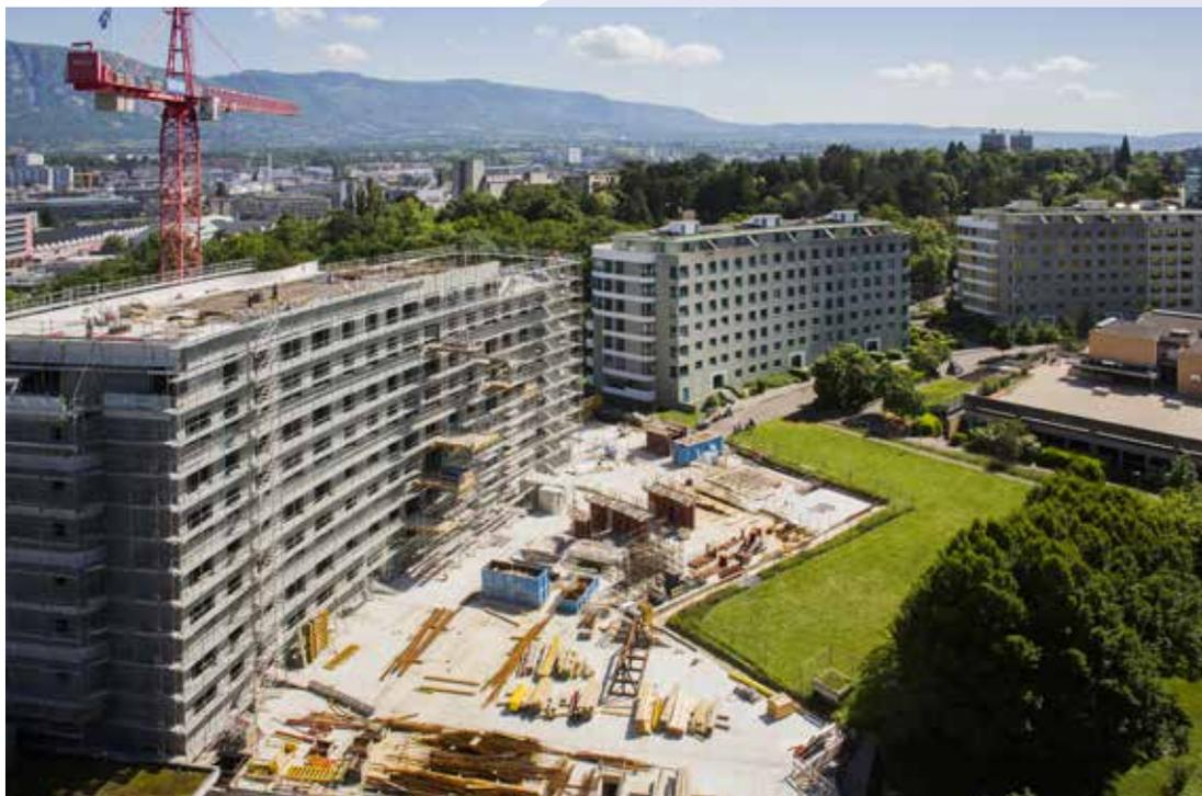
2015, le gros oeuvre s'est poursuivi par l'édification des immeubles avec, en parallèle, la pose des pièces de façade. Cette période a été mise à profit pour finaliser les détails techniques et la réalisation des éléments préfabriqués des façades, et enchaîner, les sous-sols achevés, la partie hors-sol des bâtiments.
