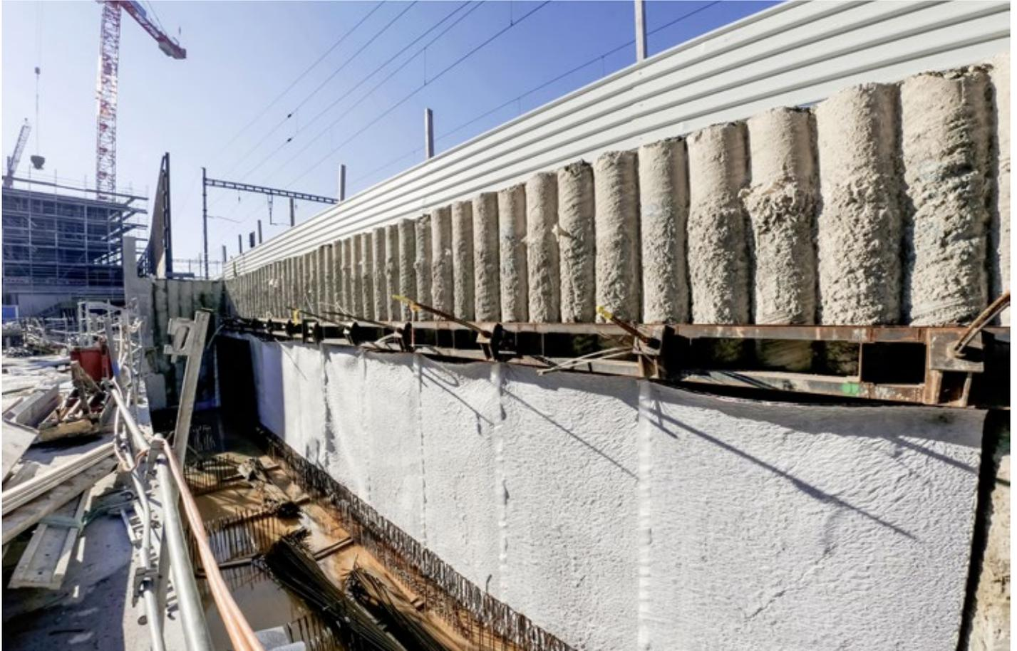
Sur près de 500 m le long de la voie ferrée, des ancrages avec pieux sécants de 80 cm bétonnés ont été utilisés. Durant toute la durée des travaux, des capteurs ont été posés pour détecter le moindre glissement de terrain ou mouvement géologique, tout particulièrement à chaque fois qu'un ancrage était détendu.
