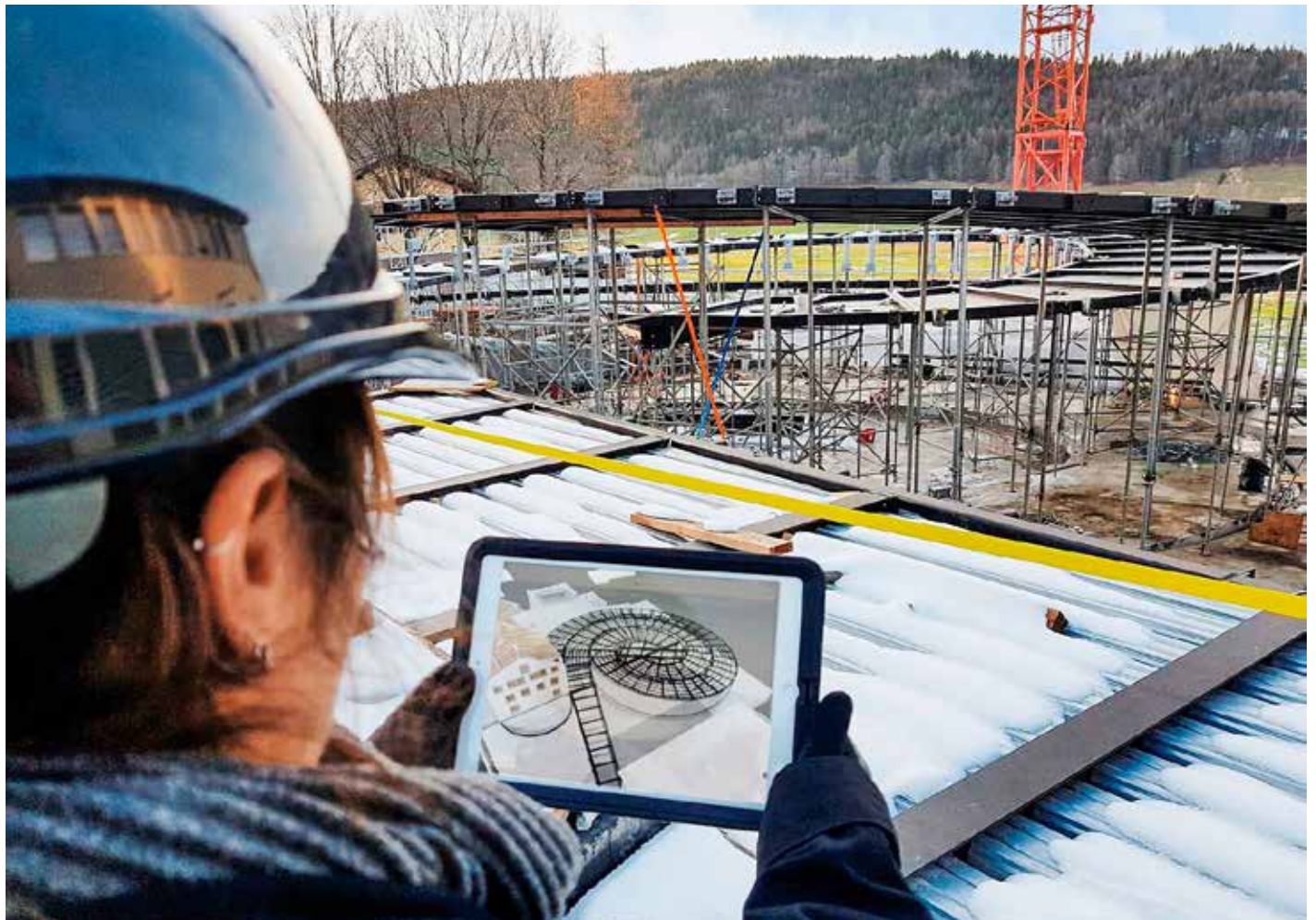
Le Musée Atelier Audemars Piguet est d'une complexité architecturale et technique insoupçonnée. Sans l'apport du BIM, il aurait été très difficile à construire, d'autant plus qu'ingénieurs et architectes devaient rester en contact permanent entre le chantier du Brassus, les bureaux CCHE à Lausanne, ainsi que les cabinets BIG à Copenhague et New York.
