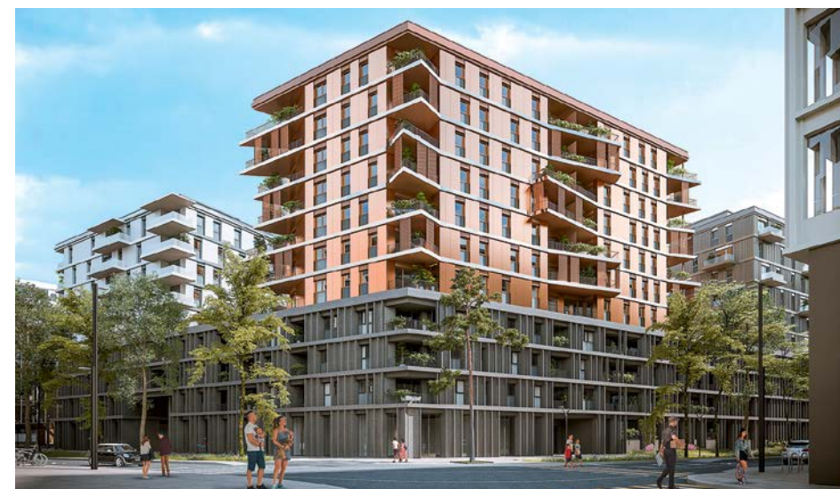
Ilot C / Le Central (habitat locatif ZDLOC) Architectes - Atelier d'architecture Grivel & Cie SA (AAG+) Entreprise totale - HRS Real Estate
