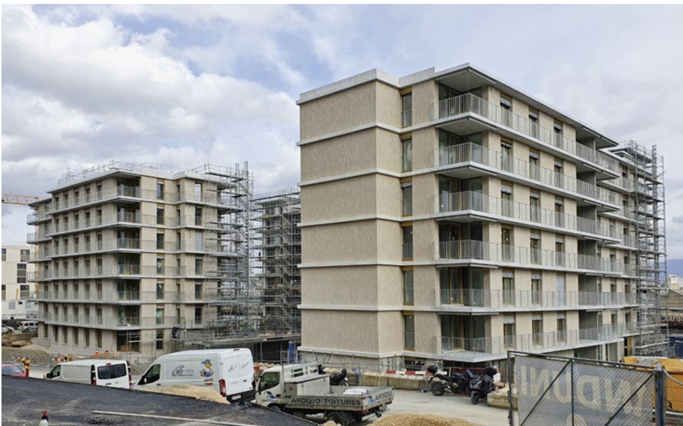
Les derniers bâtiments des lots D et E seront achevés pour cet été. Ne manquera plus que l'école pour que le quartier soit pleinement opérationnel.
