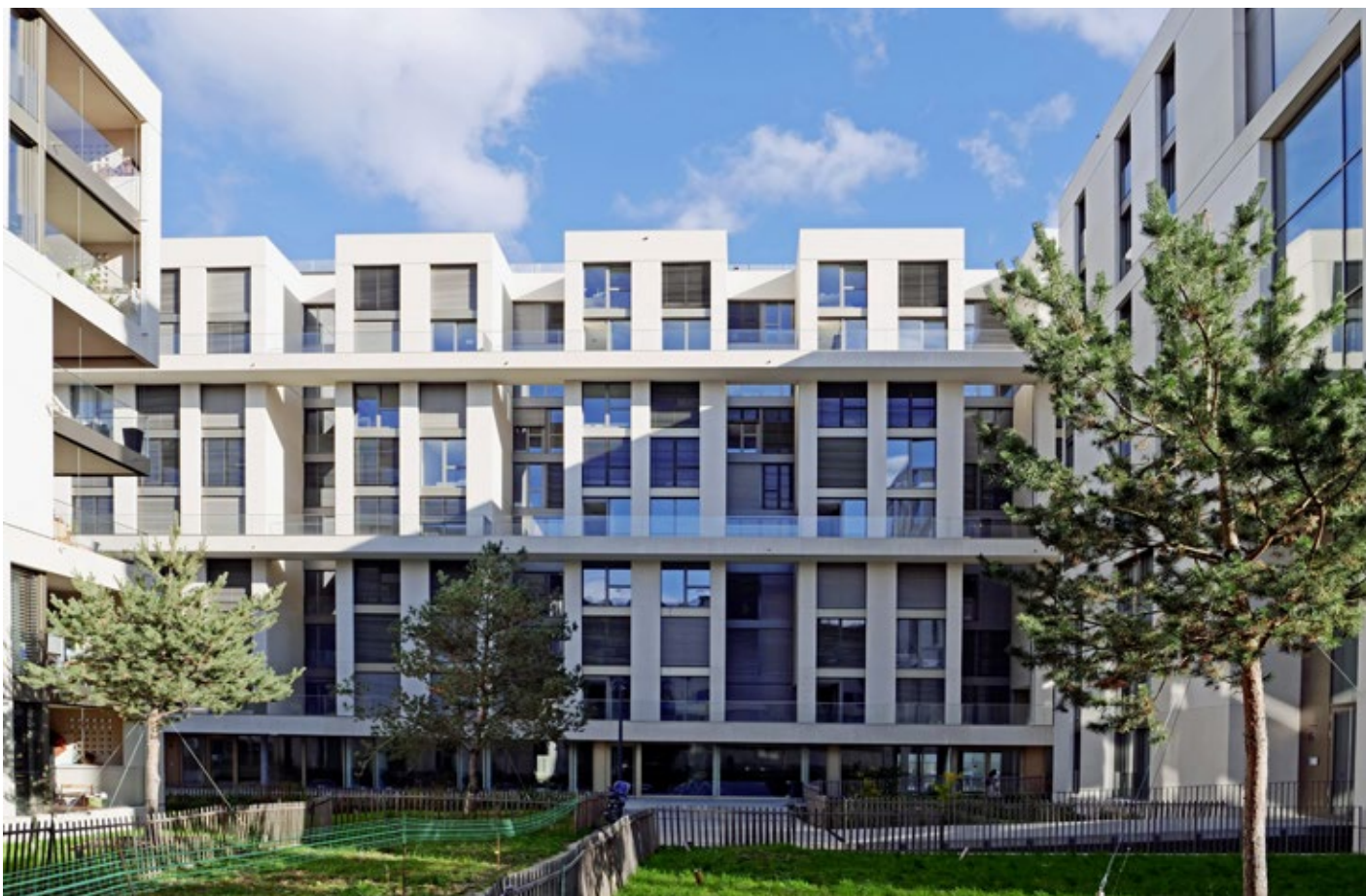
Les immeubles qui protègent de la voie ferrée se distinguent par leur face opposée avec des redents favorisant les dégagements et la multiplication des ouvrants.
