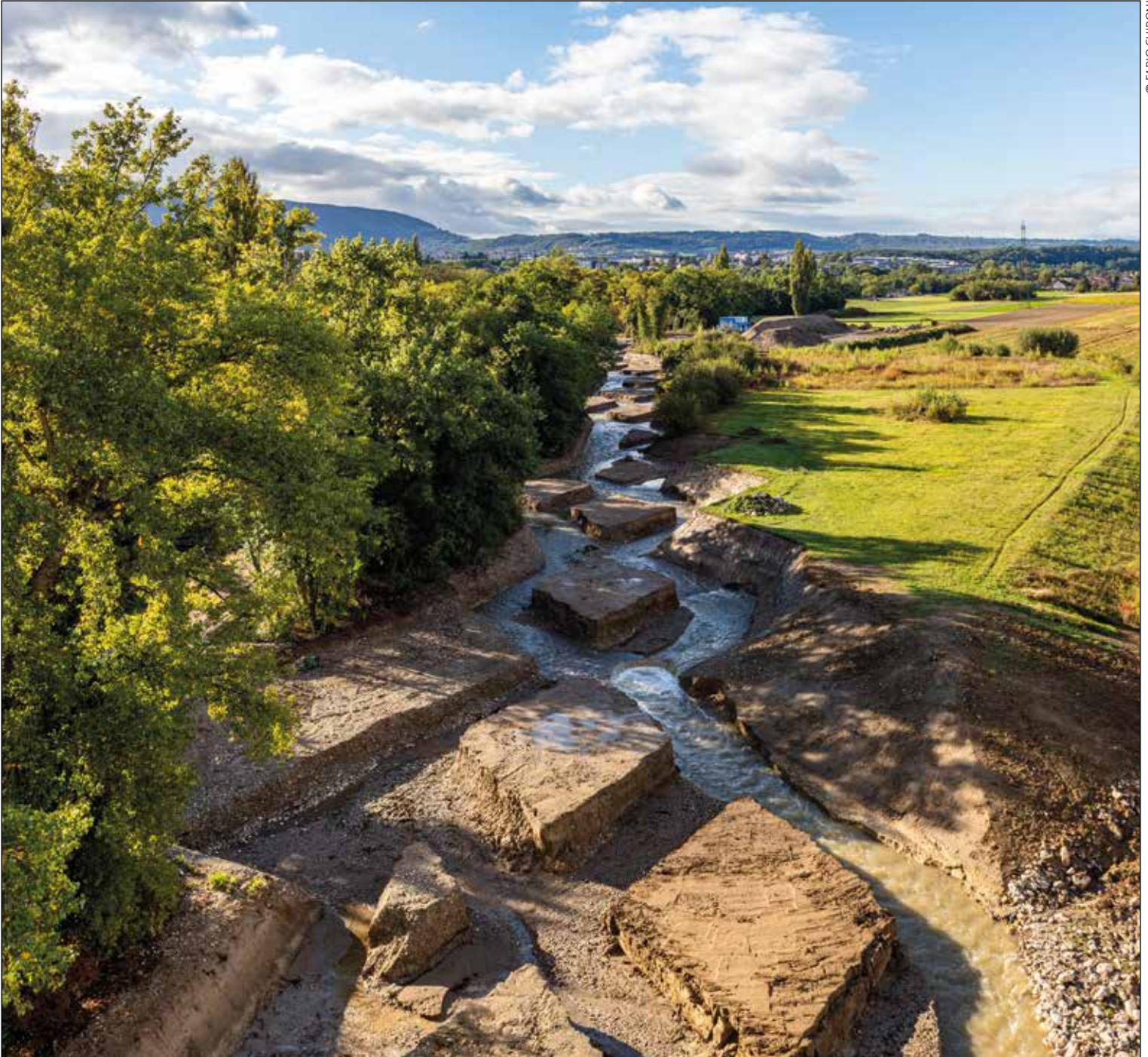
La mise en eau de losanges, un dispositif inédit qui laisse libre cours à la rivière.
