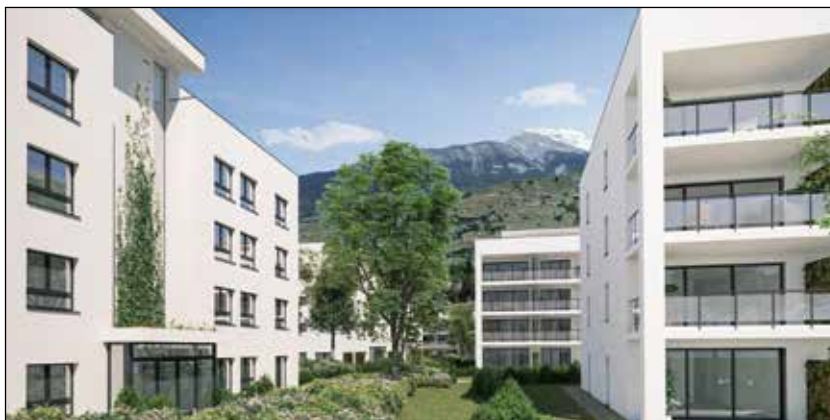
Ecoquartier «Greenparc» à Sion (chantier en cours).
