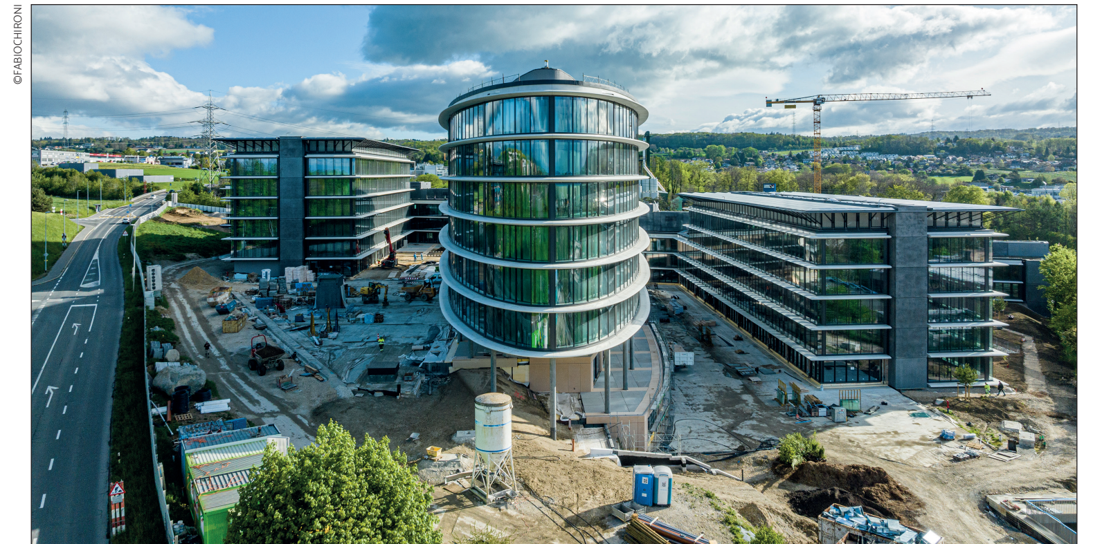
Exécution du gros œuvre en consortium pour le centre administratif Cocoon à Bussigny.
