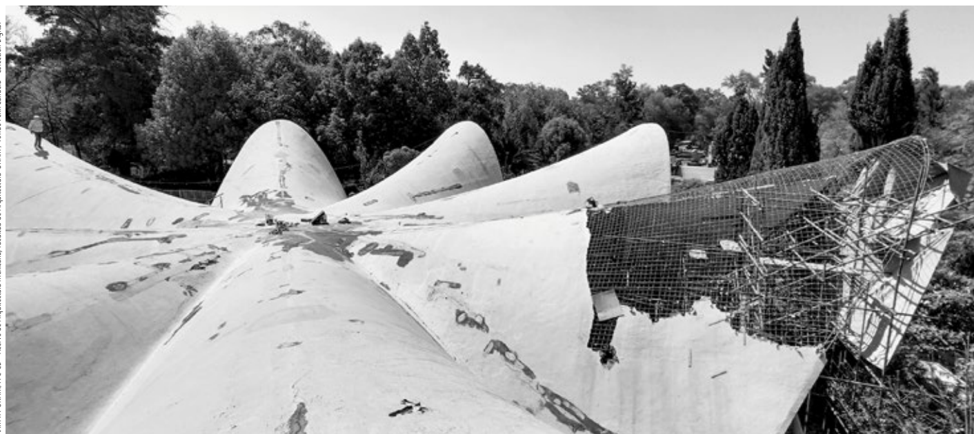
Sur les rives des canaux de Xochimilco, une zone de loisirs de Mexico, Candela a érigé en 1958 l'une de ses structures les plus célèbres : le restaurant Los Manantiales, une voûte à huit segments d'une superficie de 900 m 2 . L'œuvre a beaucoup souffert des outrages du temps et des travaux de transformation ont malheureusement dénaturé l'ouvrage.
