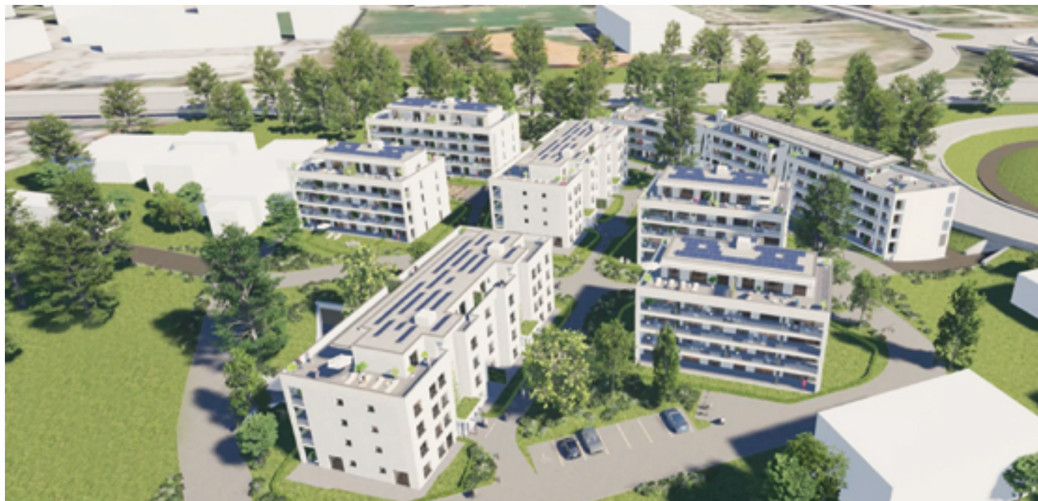
Greenparc est un lotissement en construction de huit immeubles. CSDK Architectes
