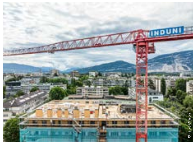
Surélévation mixte bois béton en site occupé à Genève.
